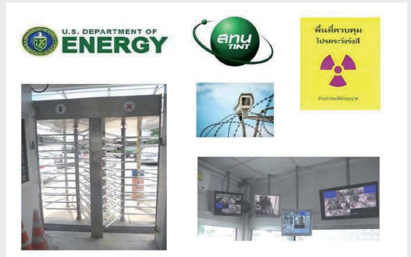
ภาพแสดงระบบรักษาความปลอดภัย 24 ชั่วโมง และระบบบันทึก CCTV ระบบการเข้า-ออก Access Control
