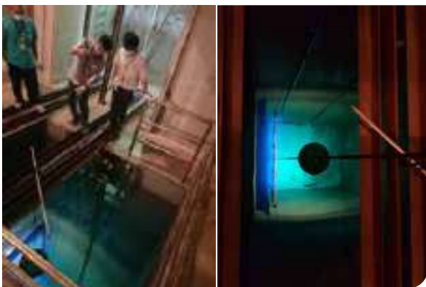
รูปที่ 9 แสดงจุดเก็บตัวอย่างน้ำจากบ่อเก็บสารกัมมันตรังสีโคบอลต์-60 (Storage Pool)
